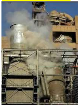
Pic. หม้อไอน้ำที่ WHR K4 ปล่อย DSH แผลกระเปิด
